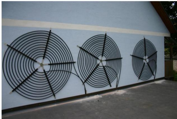
SPIRALWÄRMETAUSCHER AN FASSADE ALS BAUKÖRPERAKTIVIERUNG MONTIERT
